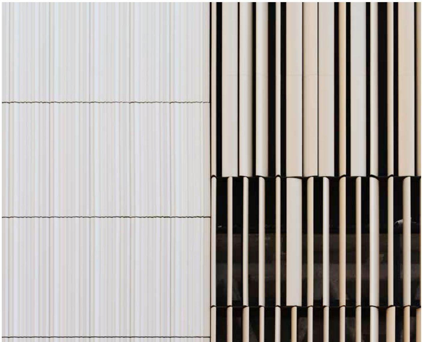
Son varias las piezas y colores utilizados en el proyecto con el fin de mantener el aspecto exótico que lo diferencia del resto de hoteles de Benidorm. Por una parte, las piezas de fachada ventilada utilizadas han sido la FS-X 37, FK16, BO 160x50 y, por otra parte, los colores empleados White Benidorm ES4245 y Black Chicago EM2129.
