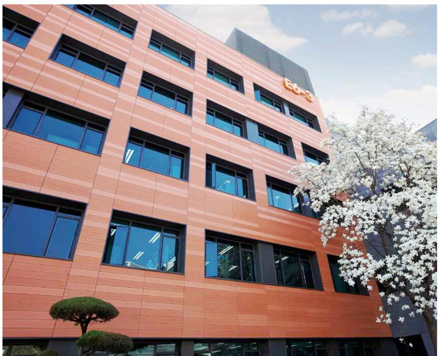
Siguiendo con la filosofía medioambiental de la universidad, la renovación del revestimiento de los edificios se llevó a cabo con la fachada ventilada Tempio FS20 en los colores Naranja NA1-07, Naranja NA15-16 y Rojo R4-24 que se utilizaron de manera combinada creando un collage que aporta dinamismo al complejo.
